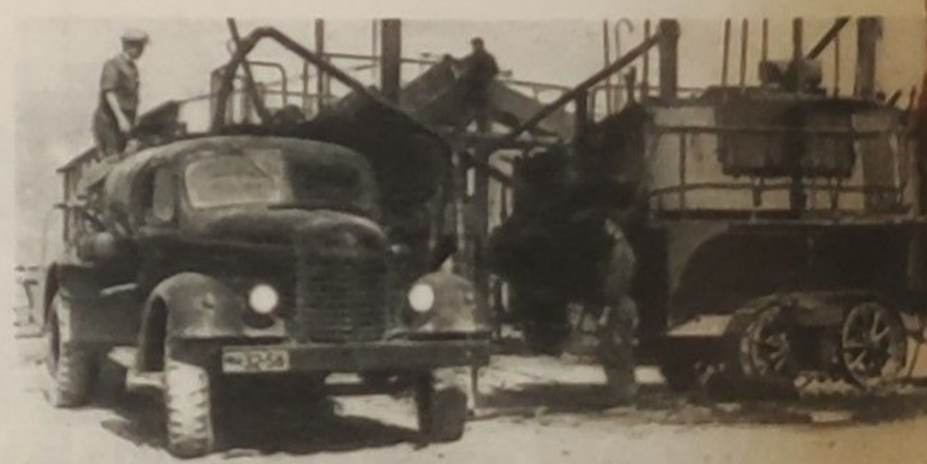
Отечественные заводы снабжают строителей газопроводов передовой техникой.
